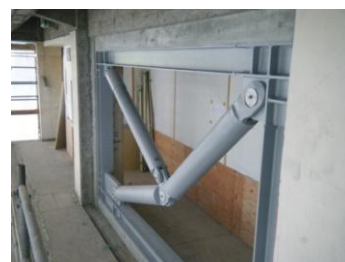
グラウト完了後
