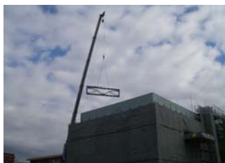
トグル装置の吊り上げ
