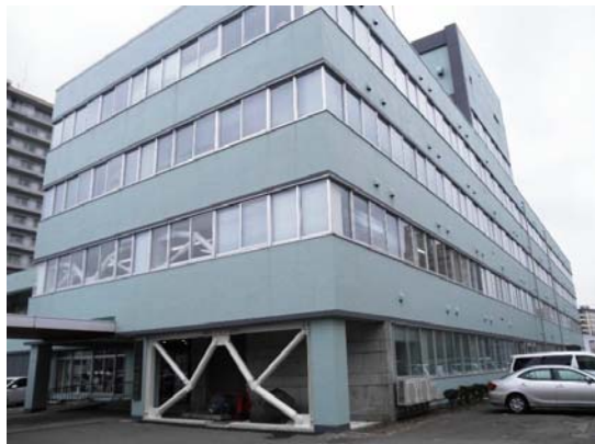
T庁舎外観 クラックなし(23年3月14日撮影)
