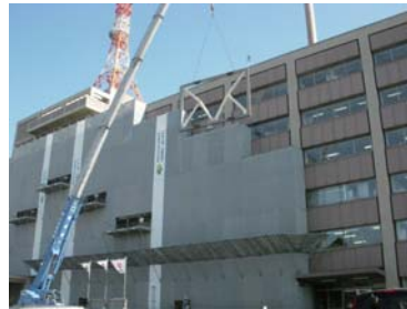
トグル装置の吊り上げ
