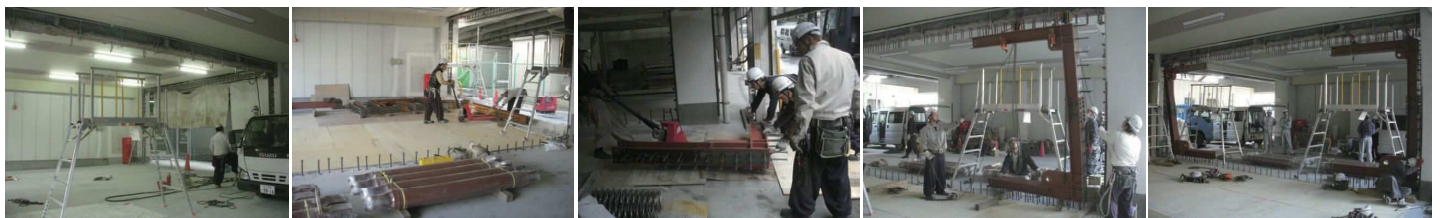
アンカー打ち
