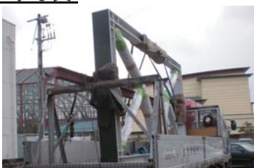
工場で作成したトグル装置をトラックで搬入
