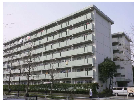
北東面施工前
