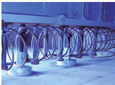
スパイラル筋設置
