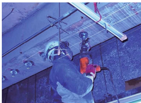
固定作業 (先端部拡張作業)
