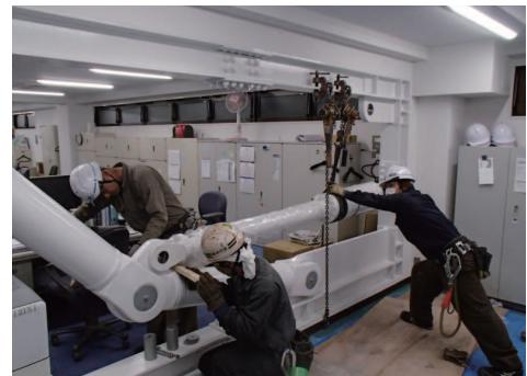
850kN ダンパーを後から取り付けました。ウィンチによる揚重で窓からの搬入ですが、ダンパーがスリムなので難なく施工できました。
