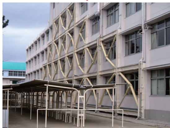
西面施工後（1期工事）
