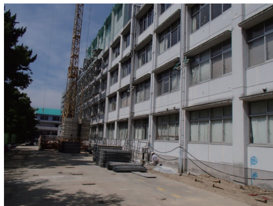
西面施工前（1期工事）
