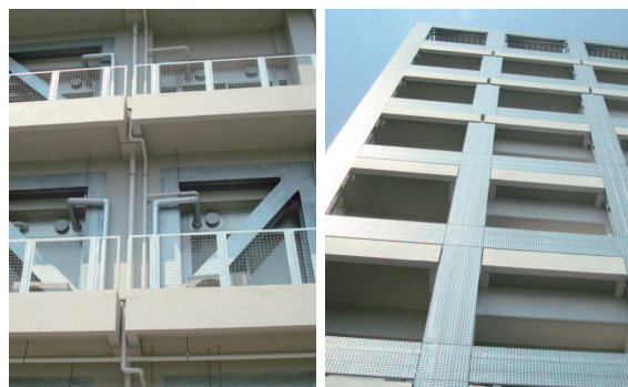
在来工法との比較（右が対象の S1 棟 CESRet 工法）
