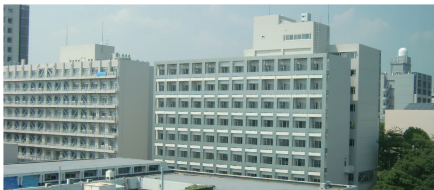
南面（右が対象の S1 棟）
