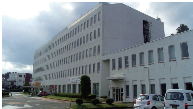
南側 (トグル施工なし)
