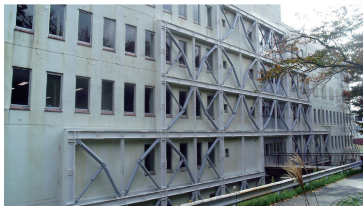
北側 (トグル施工あり)
