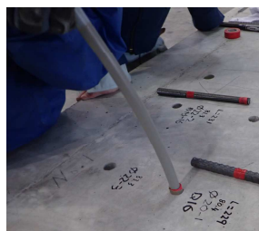
アンカー材注入
