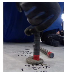
アンカー筋挿入
