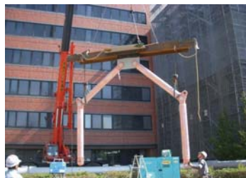
鉄骨梁・腕部材吊り込み
