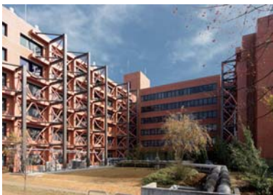
②裏側からのN棟 写真②
