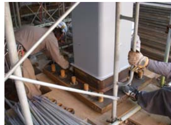
鉄骨柱材取付
