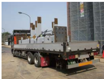
鉄骨部材搬入
