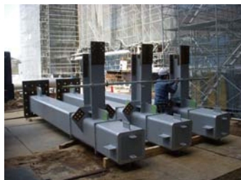
鉄骨柱仮置き
