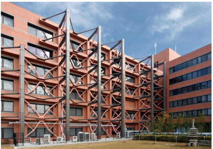
裏面（左側がN棟）
