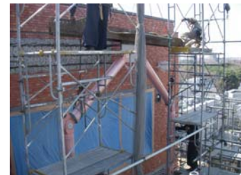
鉄骨梁・腕部材建方
