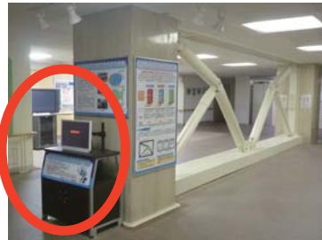
1Fロビーに設置している地震観測表示モニターとトグル制震装置
