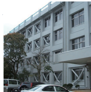
神戸大学附属明石中学校 (2008年竣工)
