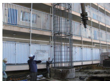
造成杭鉄筋立て込み
