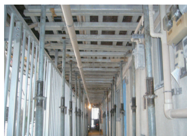
スラブ補強型枠（吊型枠）
