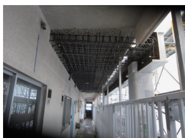
スラブ補強鉄筋組立
