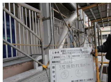
制震装置腕部材取付
