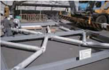
腕部材・ダンパー取付
