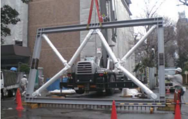
トグル装置の吊り上げ
