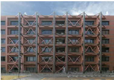
①正面側からの S 棟
