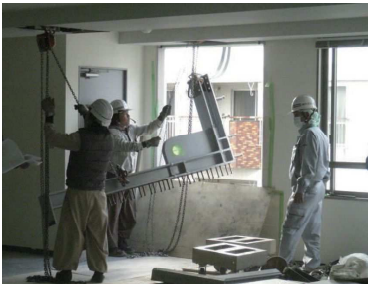
トグル枠の分割吊り込み
