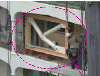
吊り込み・移動
