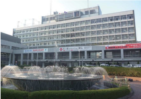
南面外観（正面）
