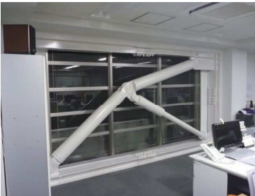
施工後執務室内
