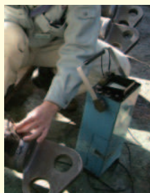
⑦第三者UT検査
