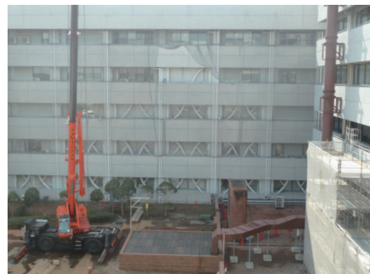
トグル施工中
