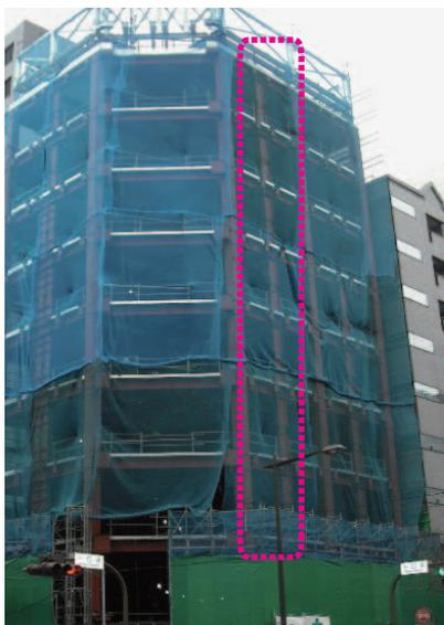
レンズ型制震ダンパー設置面
