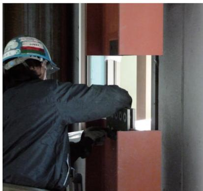
施工の様子（間柱中央がダンパー）
