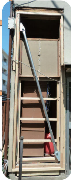
単体ダンパー取付け状況
