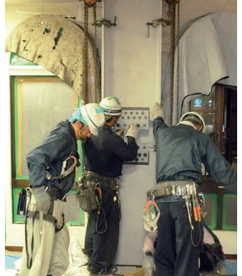
レンズダンパー仮ボルト入れ状況
