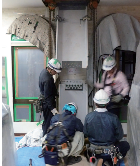
上側間柱建て込み状況
