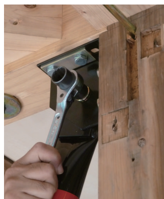
ダンパー取付け
