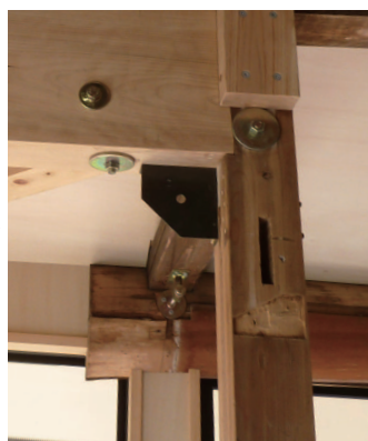
接合金物（ハードロック）取付け
