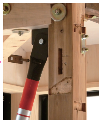
ダンパー取付け完了
