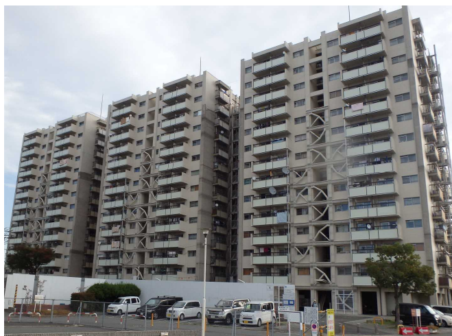
第1工区西面全景
