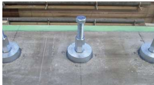
断面修復工法施工完了
