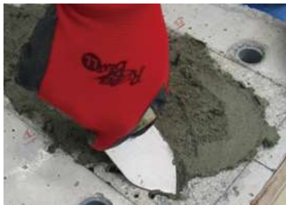
断面修復工法施工状況
