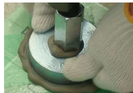
無機系接着剤による施工
