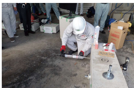
無機系接着剤による施工
