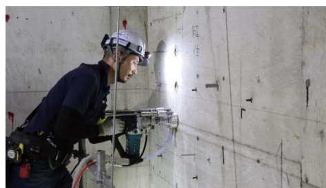
ブラストキー施工状況
