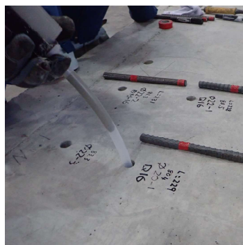
アンカー材注入
