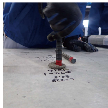
アンカー筋挿入
