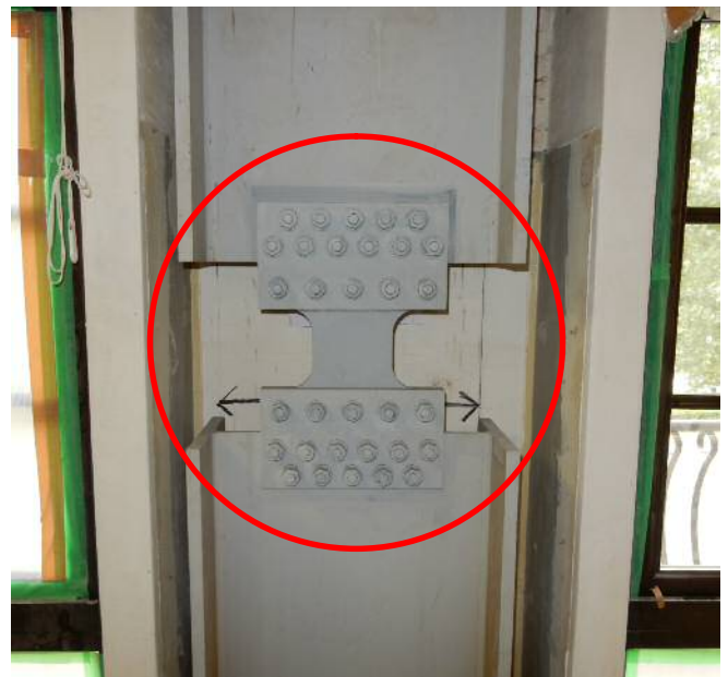
写真－3 レンズダンパー設置状況
