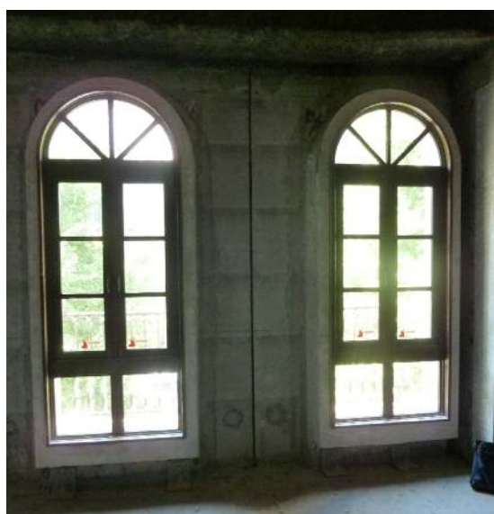
写真-4 既存状態
