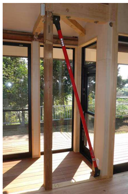
写真1 木造用リング摩擦ダンパー取付状況 (耐震改修事例)
