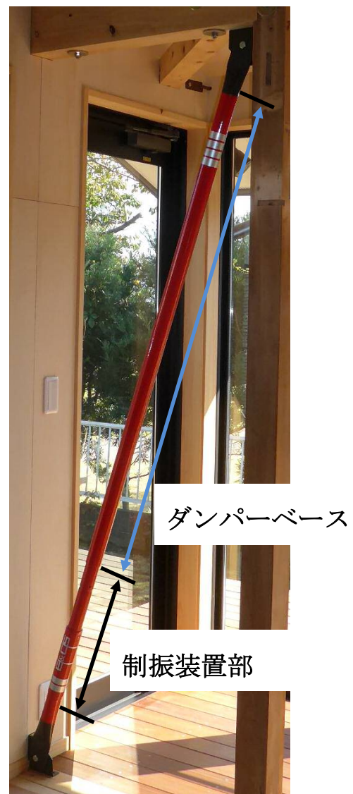
写真4 木造用リング摩擦ダンパー全体（取付状況）
